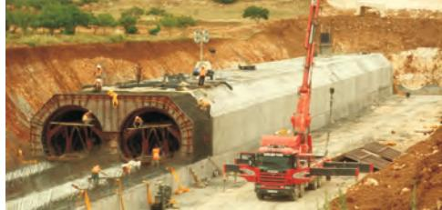
SURÜC PLAIN PUMPED IRRIGATION MAIN TRANSMISSION CANAL
